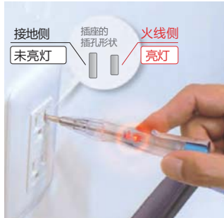
电气线路、插座的通电检测以及AC火线/地线的极性识别。
